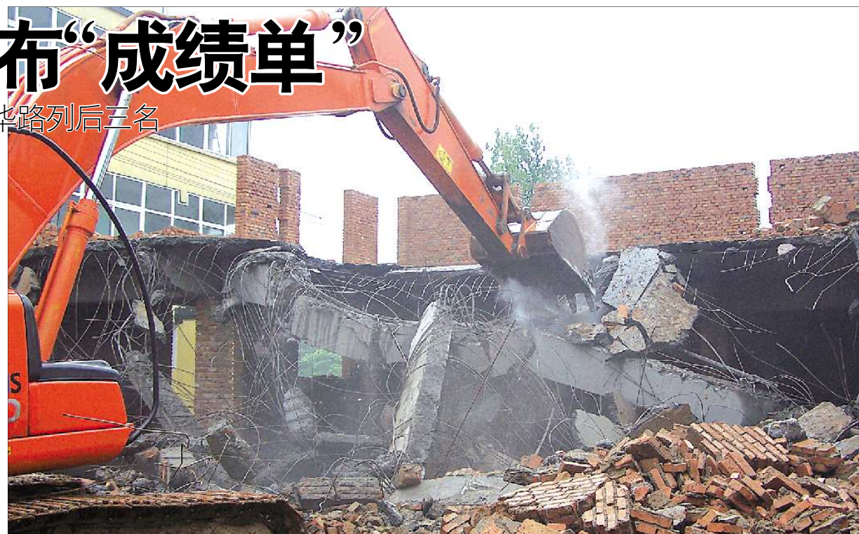
▲20日上午,天桥区和药山的冒雨强拆行动中,挖掘机在铲除乱搭乱建的违章房。
