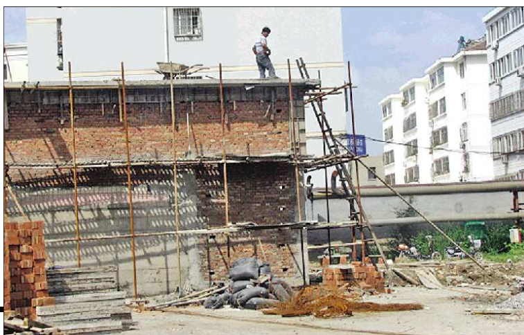
小区正在建设供热站。
