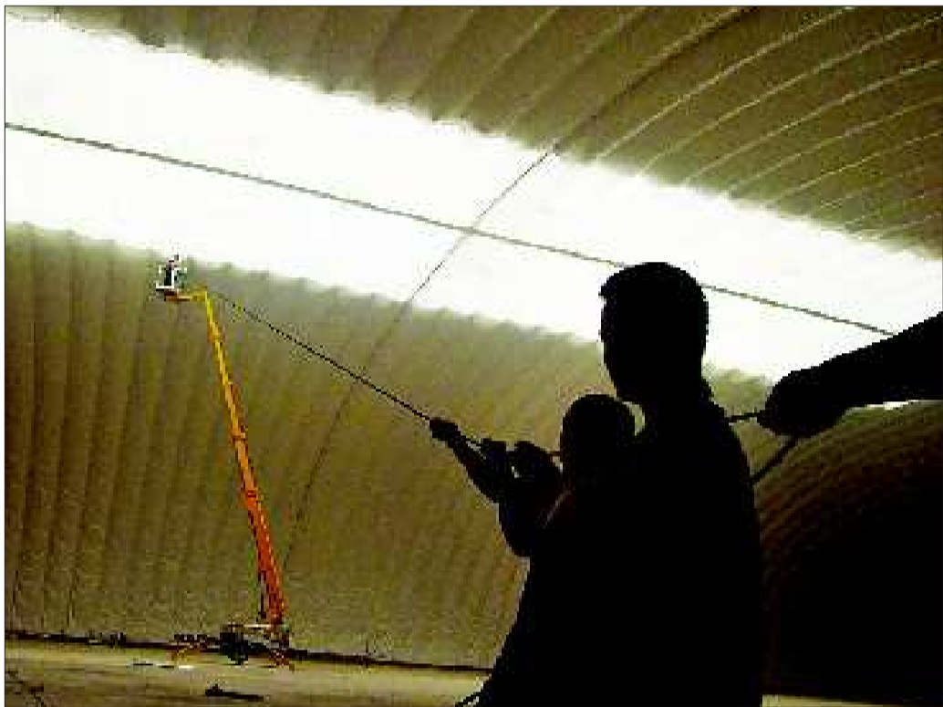
9月6日,工作人员正在方形充气展厅安装保温层。
