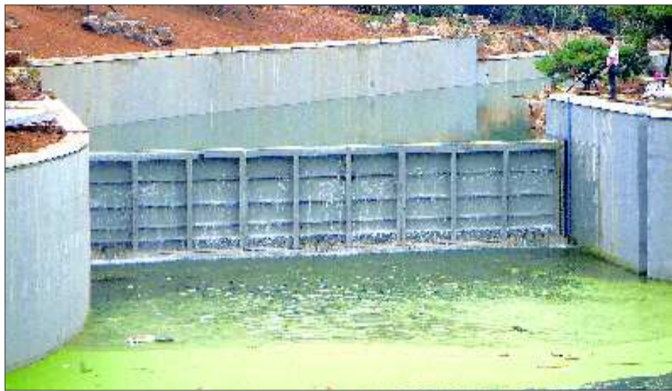
东护城河船闸进行带水试压 记者 王光营 摄
