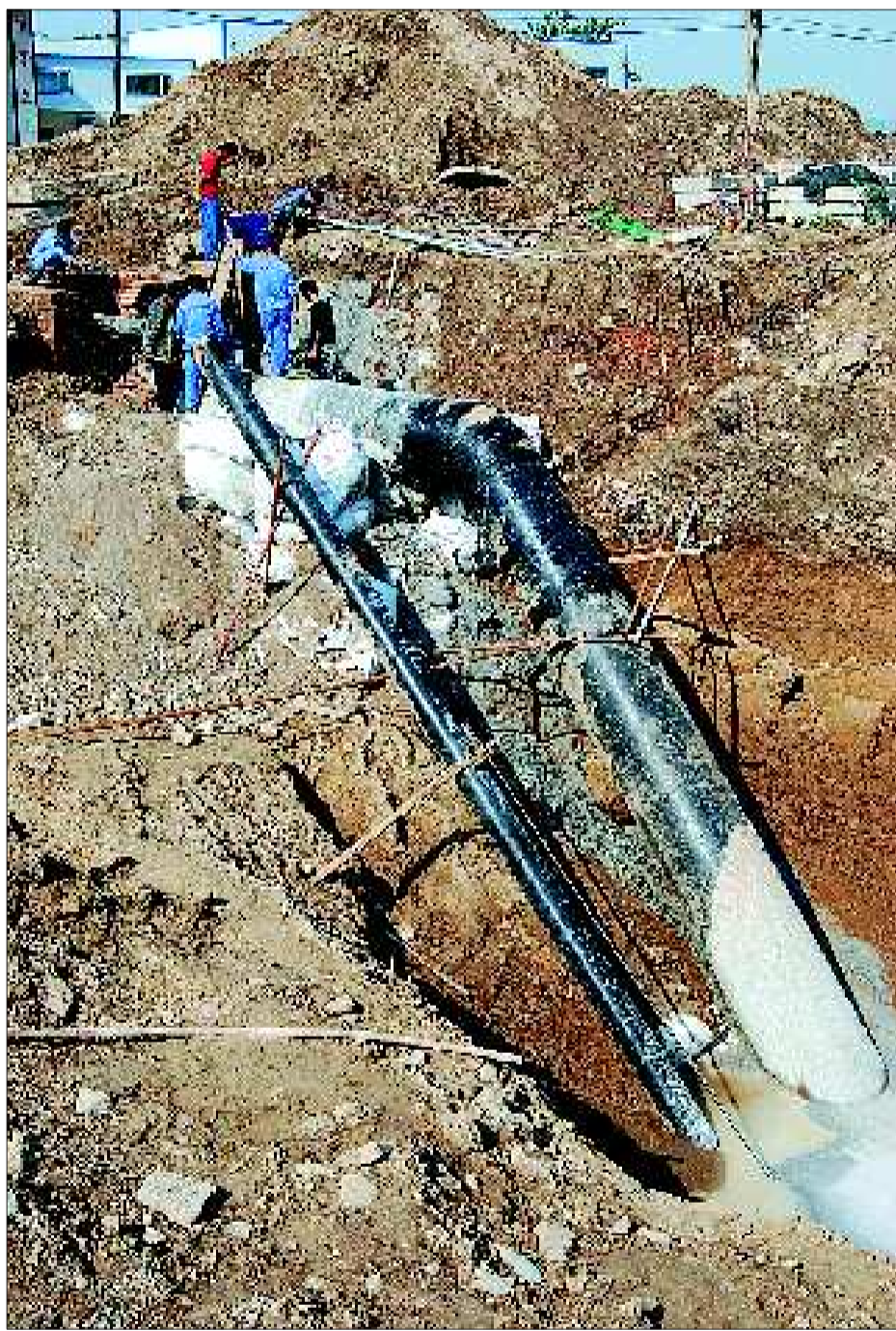
工作人员正在对无影山北路附近的管道进行加压测试。
