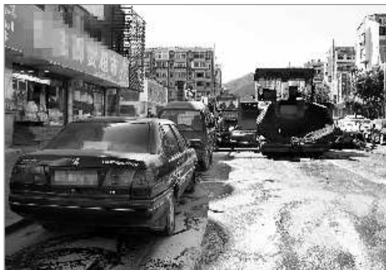
私家车挡住道路，工人无法施工。
