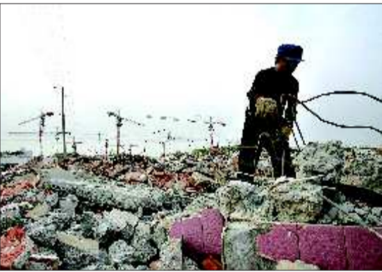
一名工人在位焦村拆除的老房子上截取钢筋,他身后的龙城国际社区正在崛起。
