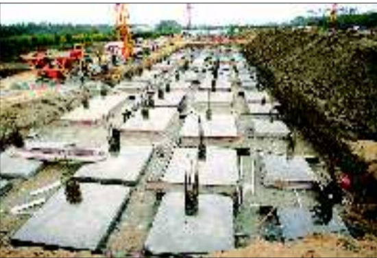
王格庄社区的工人正在打地基。
