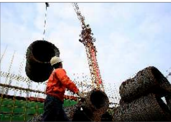
龙城国际社区(位焦村)的工地上,工人正在施工。
