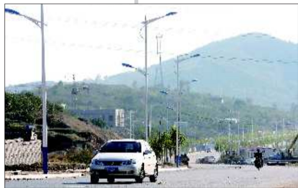
由排水处施工的路段中,已完成500米。 本报记者 赵金阳 王鸿光 摄
