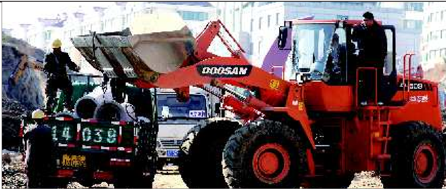
正在施工中的秦山路。
