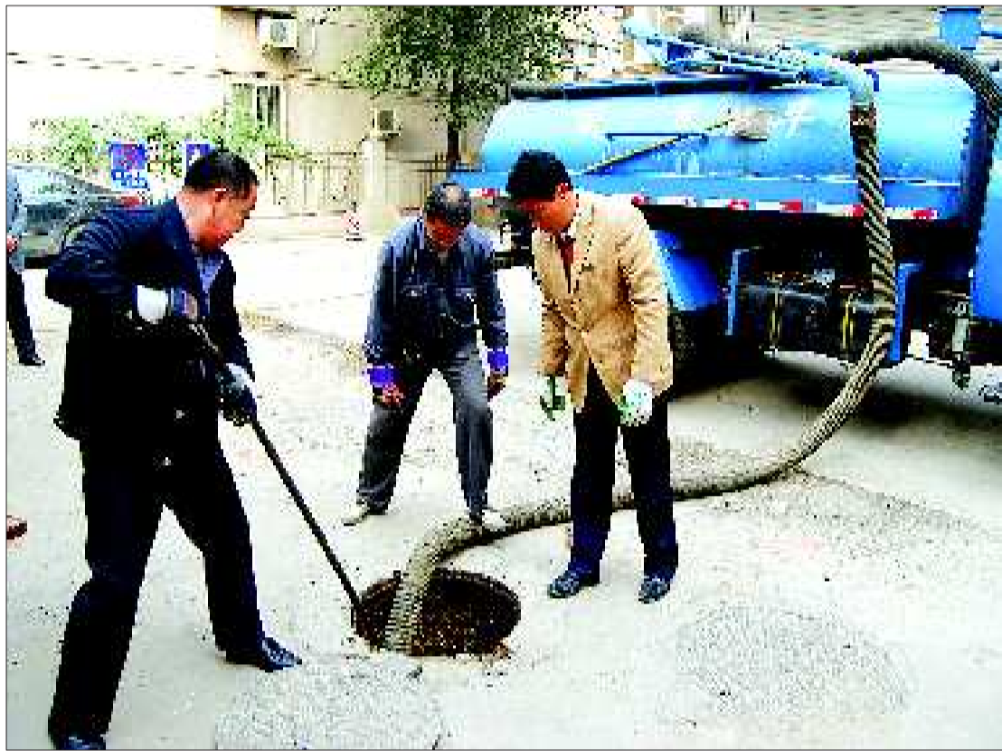
城肥清运管理二处工作人员正在清理化粪池。记者 赵伟 摄
