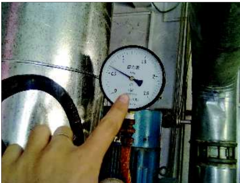
负责山大路南头几个小区供热的武警供热站,机器已经开始运转。
