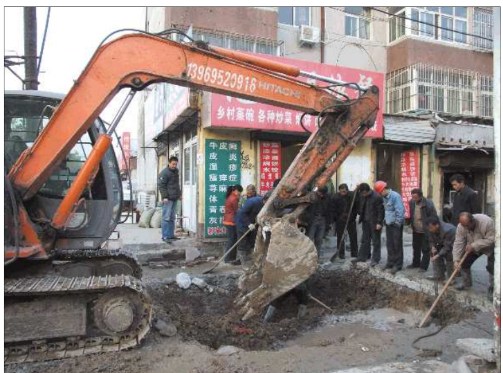
15日下午,昌润供热公司的施工人员,对卫育路一处漏水的暖气管道抢修。据了解,管道故障不会对附近居民的供暖造成影响。 见习记者 李璇 摄
