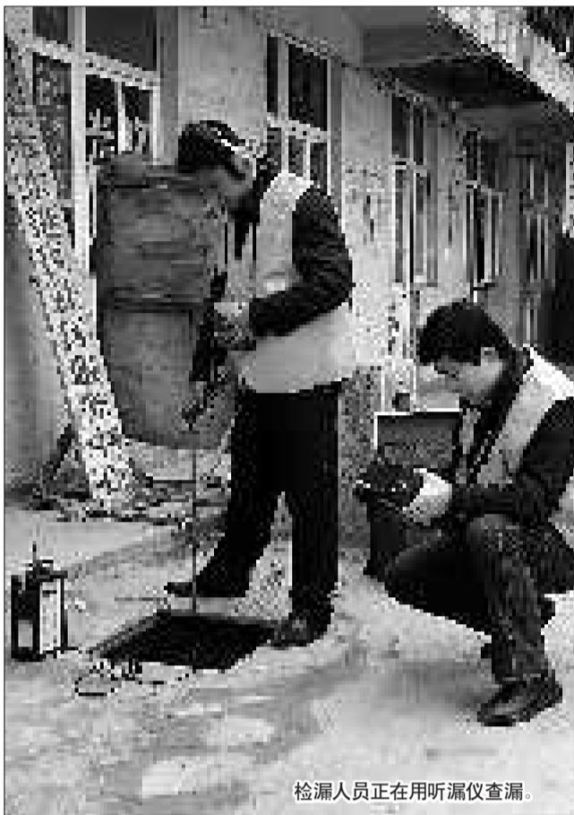
检漏人员正在用听漏仪查漏。
