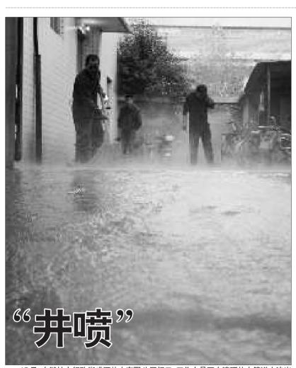
17日,在潍坊市行政街盛源热力有限公司门口,工作人员正在清理热力管道内流出 的热水。据了解,当天下午3点左右,热力管道上的一个主阀门出现问题,热水从损坏的阀 门涌出来。为此,老市府东院宿舍的供暖受到影响。工作人员介绍,只要管道的压力降下 来,更换阀门就可以,当天下午就可以完成更换。记者了解到,自供暖以来,这种"井喷事 件"已经出现过多次了。 本报记者 孙国祥 摄影报道
