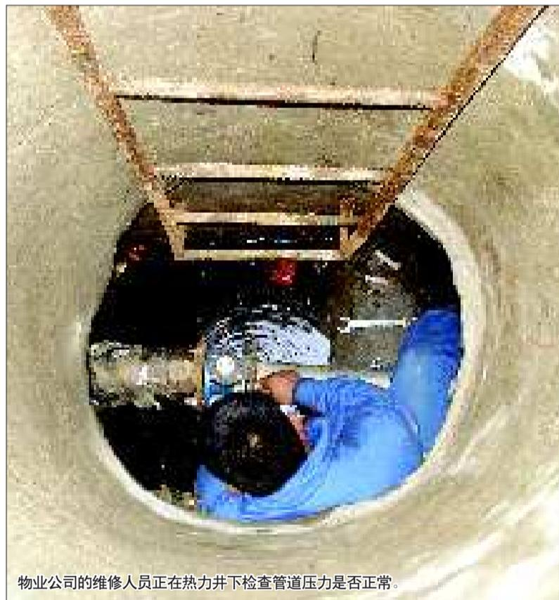
物业公司的维修人员正在热力井下检查管道压力是否正常。
