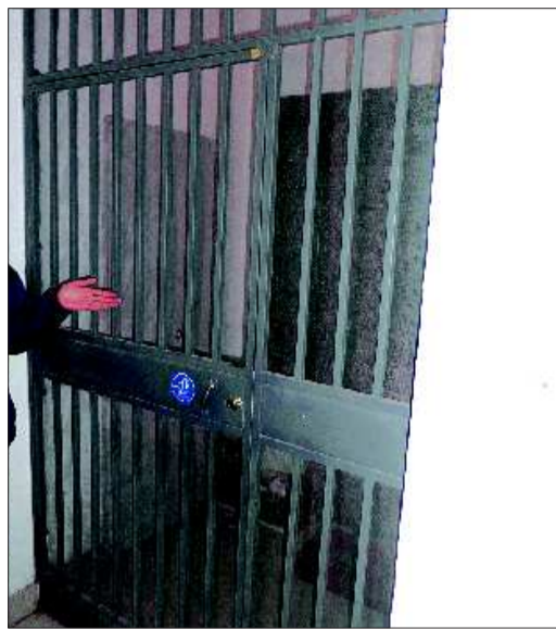
防盗门把管道井也锁在了里面。见习记者 陈伟 摄
