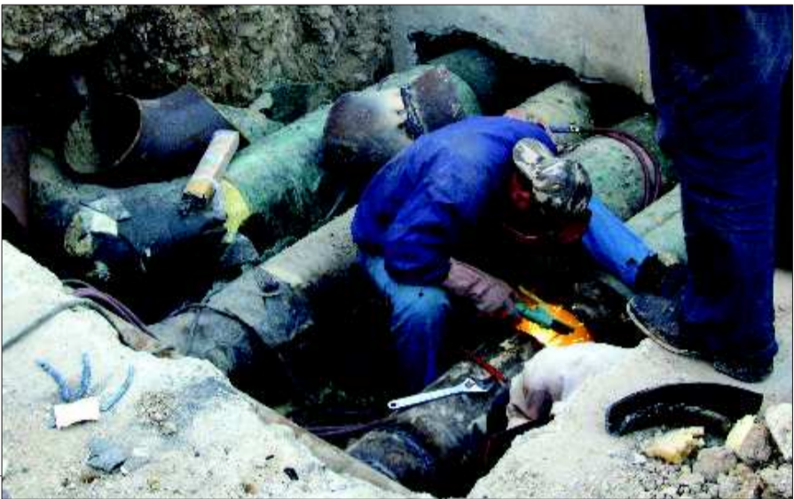
工作人员正在给金都花园小区的供热管道“调头” 本报记者孙翔摄
