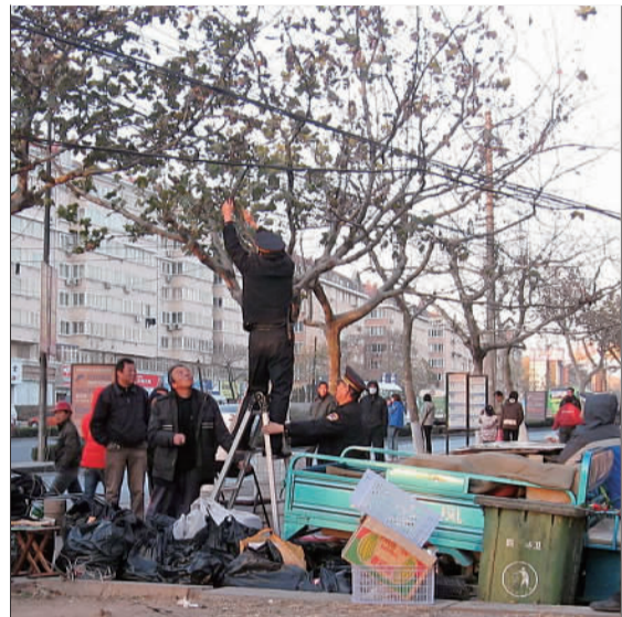
执法人员正在拆除私设的电线。 本报通讯员 杨志衍
