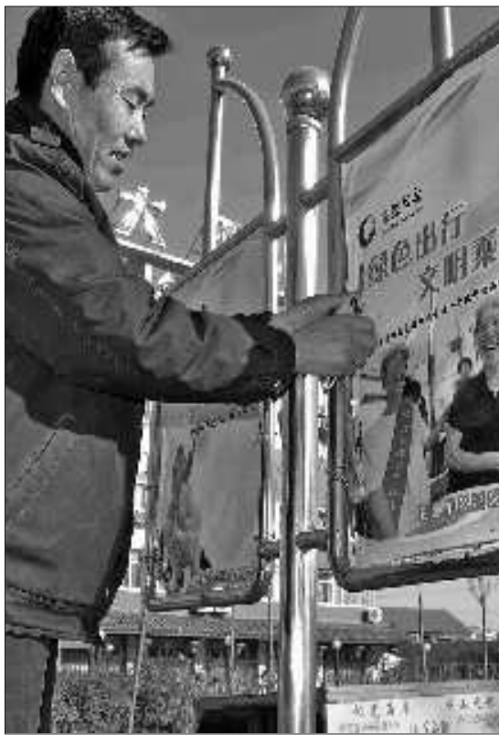
公交公司工作人员正在维修站牌。
