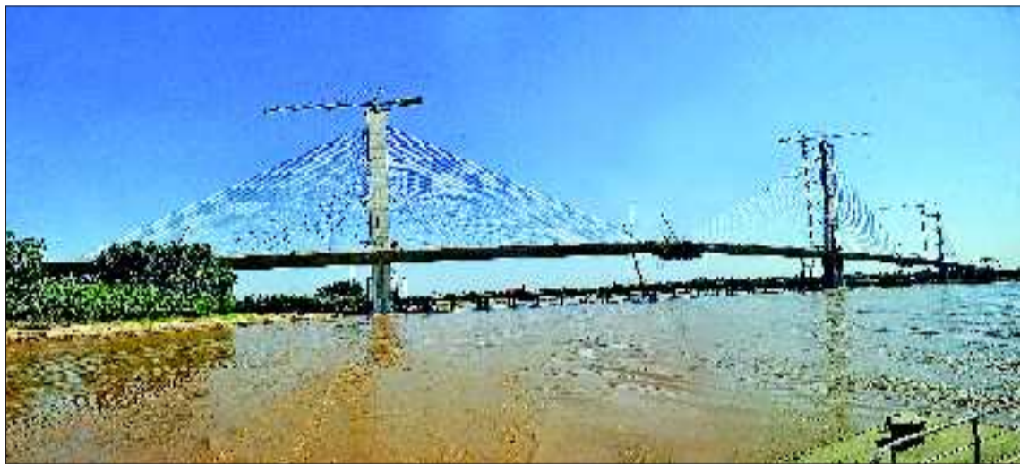
建设中的建邦黄河大桥。本报记者 徐延春 摄于2010年10月4日
