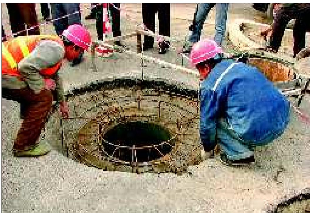
12日,文化路上的施工人员正在进行检查井加固,将钢筋笼铺在井口外围,“咣咣”响的井盖子将成为历史。
