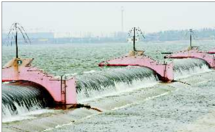
沂河上的小埠东橡胶坝正在向下游放水 记者 廖杰 摄
