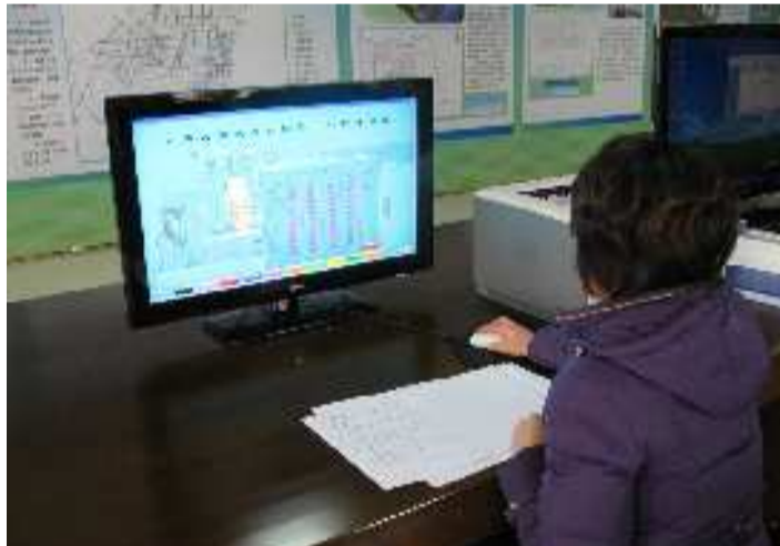
工作人员在中水站控制中心监控污水处理。
