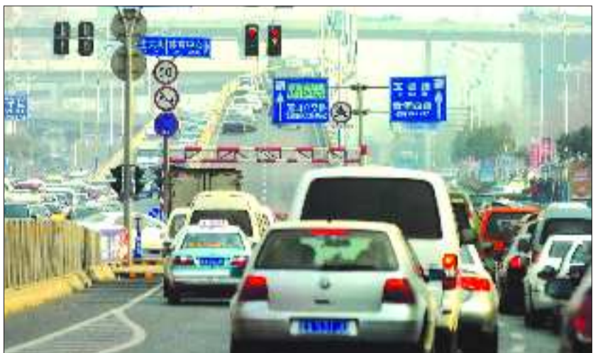
25日,经十路玉函立交桥,桥上桥下都是车,连上行的车道都成了停车场。
