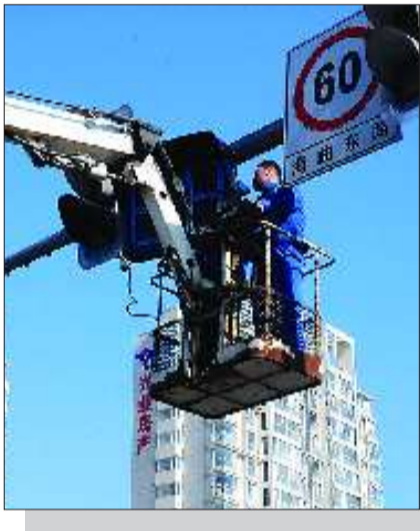
1月25日,在北京路与海曲东路交汇处,交警直属大队工作人员正在对信号灯进行更换。
