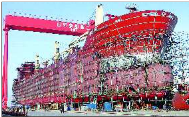
威海船厂5万吨级船台及400吨龙门吊。(资料片)
