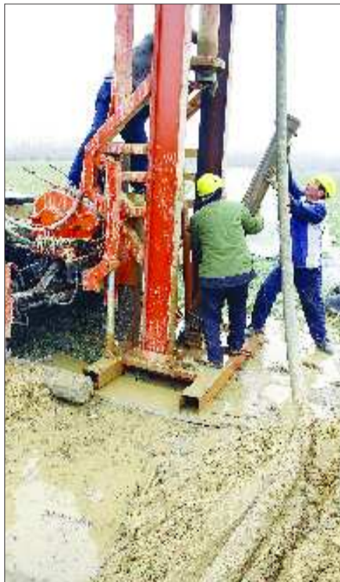
在郯城县庙山镇的田间,郯城县抗旱服务队正在紧张地打井作业。 胡志英 摄
