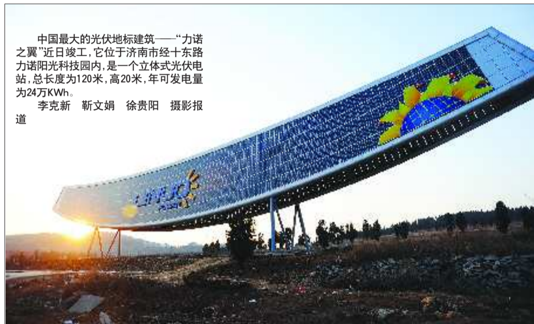
中国最大的光伏地标建筑——“力诺之翼”近日竣工,它位于济南市经十东路力诺阳光科技园内,是一个立体式光伏电站,总长度为120米,高20米,年可发电量为24万KWh。
