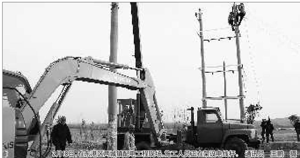
2月18日，在东港区两城镇配电网工程现场，施工人员正在架设电线杆。通讯员 王鹏 摄
