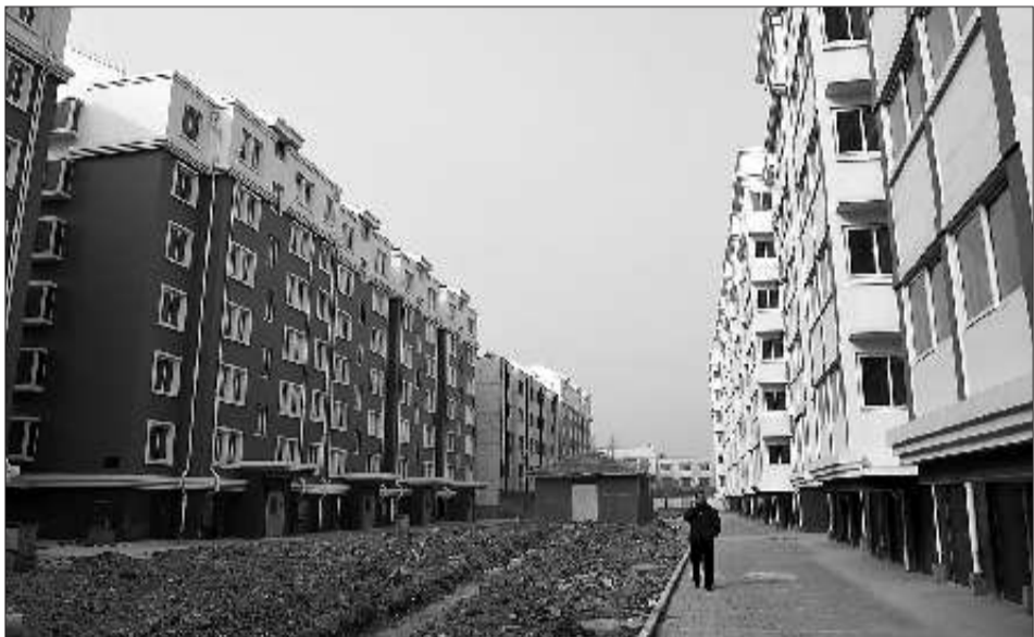
▲济宁城区的保障性住房小区温馨家园居民楼已通过竣工验收。
