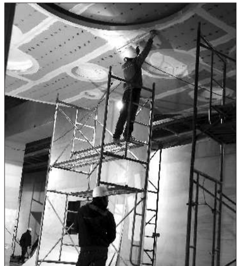
工人紧张施工。
