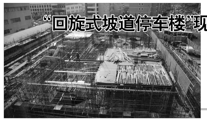
8日,从高处俯瞰燕儿 岛路靠近香港中路处的坡 道式停车楼,地下三层的 施工已接近尾声。据了解, 坡道式停车楼分为地下三 层,地上七层,其中地上一 层承接汽车美容与修理等 业务。建设方技术负责人 肖师傅介绍说,停车楼采 用回旋式坡道,总建筑面 积达15240.71平方米,建成 后可容纳138个停车位,一 定程度上能缓解周边停车 难的状况,预计整个工程 在6月30日前后完工。
