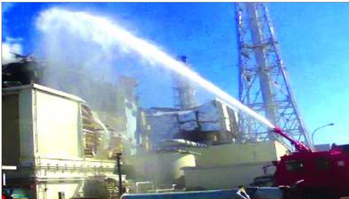
3月19日，消防车正在对福岛第一核电站的5号机组采取喷水降温作业。
