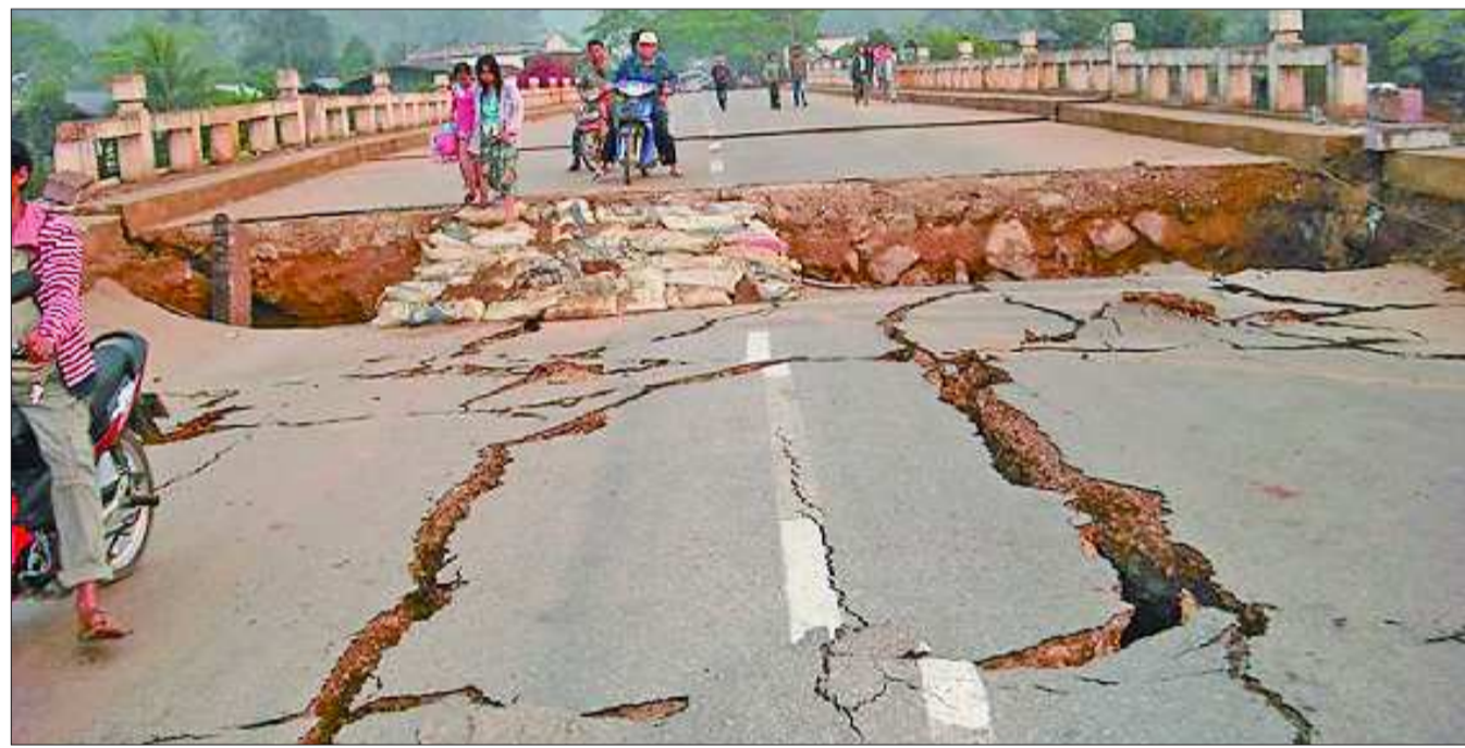
3月25日,人们在缅甸塔莱镇的一条被震裂的道路上行走。 新华社/路透
