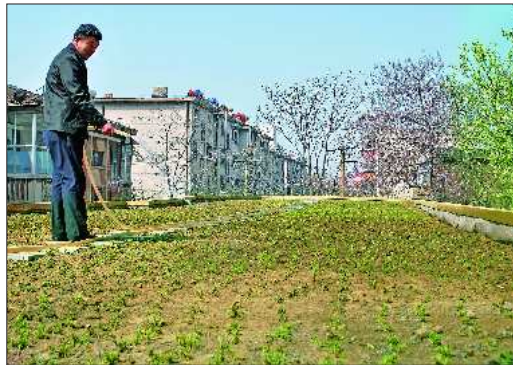
工作人员正在给“屋顶绿化”样板工程的草皮浇水。 本报记者 刘守善 摄
