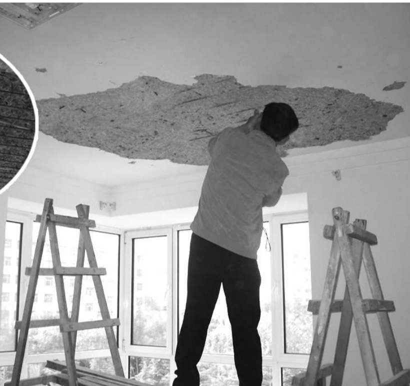
▲客厅天花板上钢筋、沙子、石子都裸露在外面
