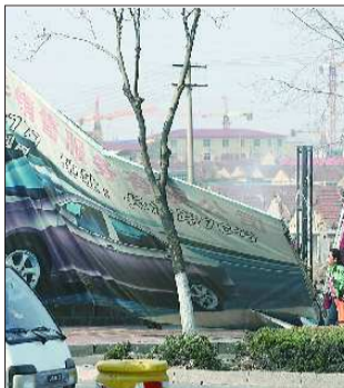
18日,青岛一块广告牌被大风吹倒。(资料片) 杨宁 摄
