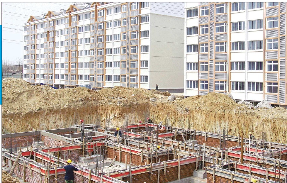
正在建设中的廉租房
