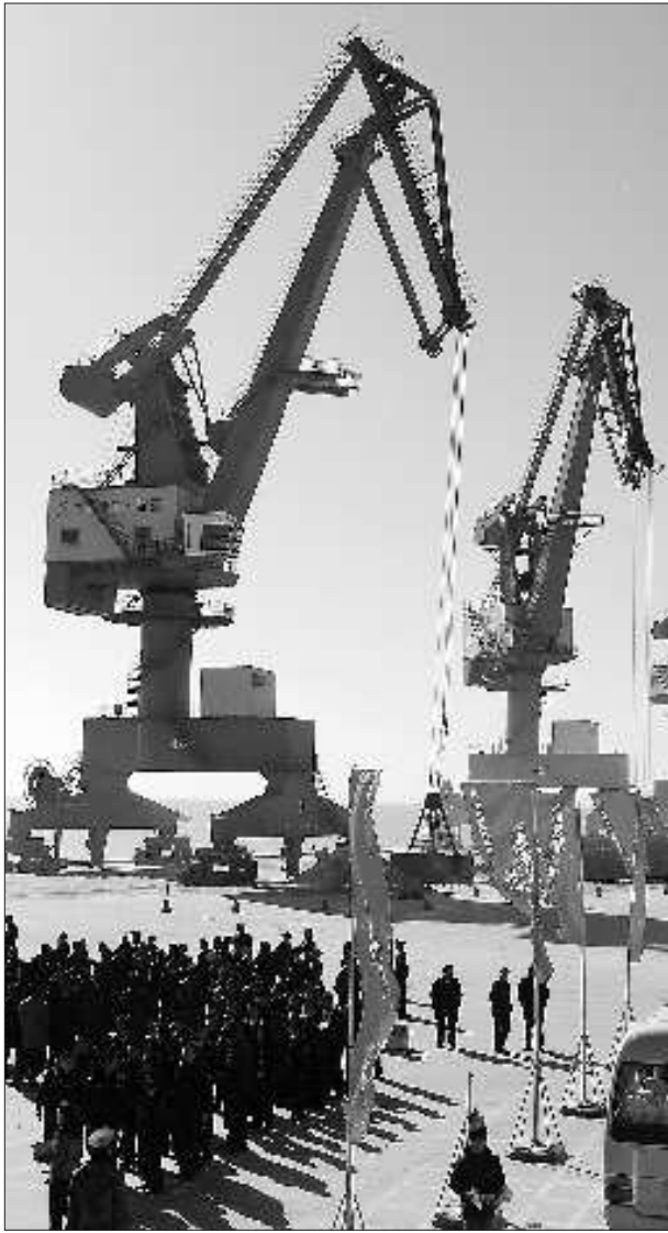
2010年11月,东营港2×5万吨级液体化工码头开工。(资料片)
