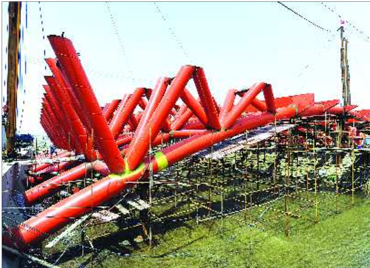
正在施工的黄岗路桥雏形初具。 本报记者 王媛 摄
