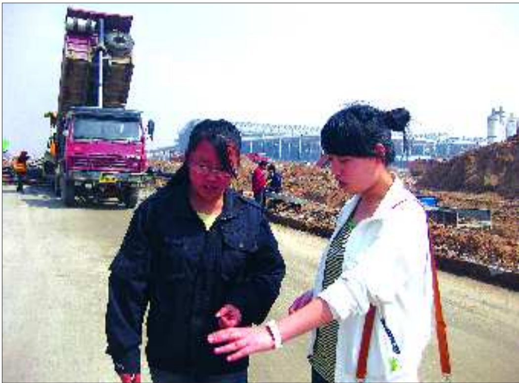
张晓伟(右)在西客站片区站西路施工现场请教问题。
