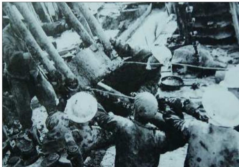
▲会战初期,石油职工正在进行下套管作业的施工现场。(资料片)
