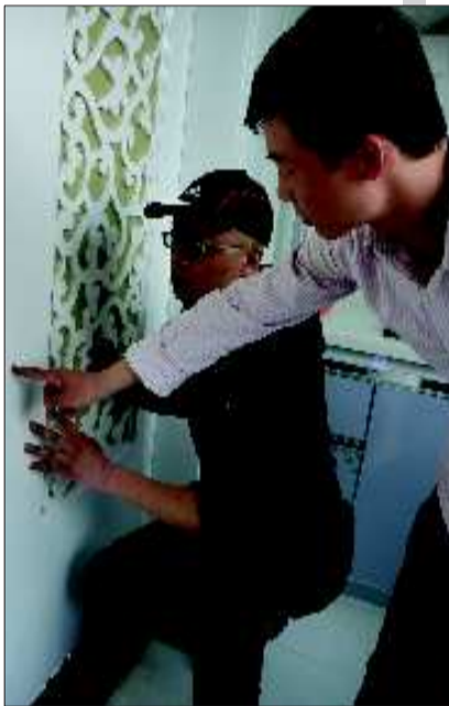
装修结尾,王清华(右)正在进行工程验收
