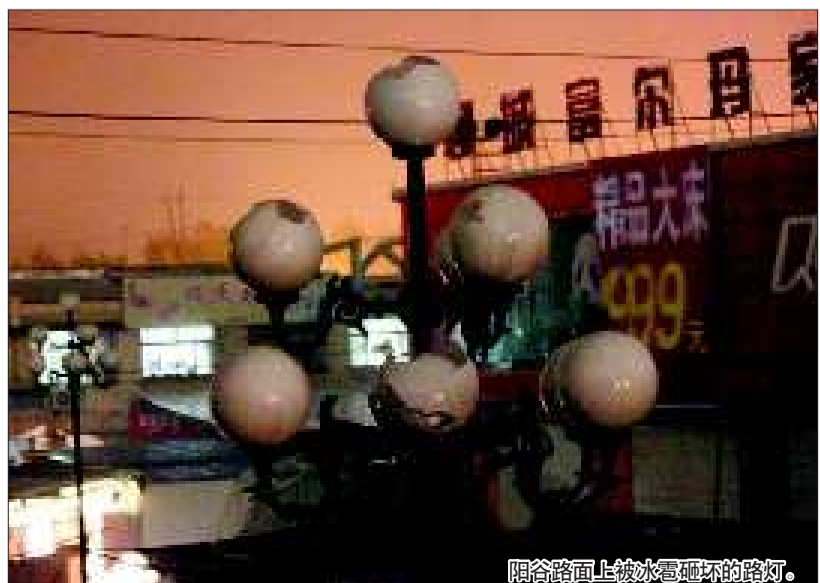
阳谷路面上被冰雹砸坏的路灯。
