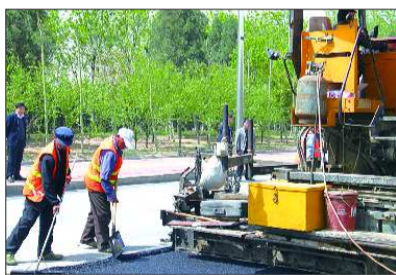
5日,工人们正在紧张施工。 本报见习记者 王媛媛 摄
