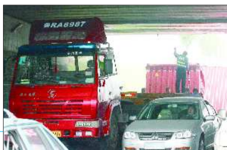
桥体脱落 集装箱却撞上桥 货车车头通过了
