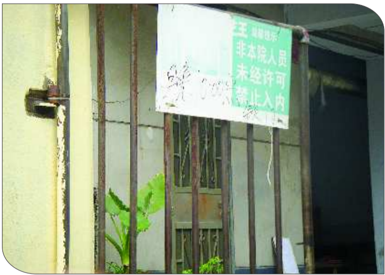
▲南坛小区一号楼门口处悬挂着锁门通知。记者 吴慧 摄
