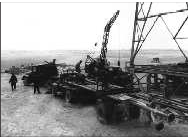
1966年, 钻井3268队工人们正在紧张有序地搬迁。(资料片)
