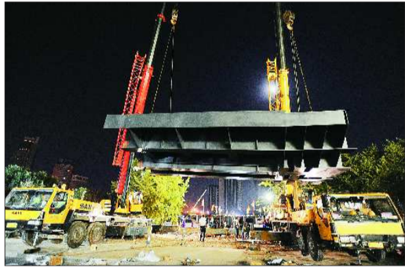
两台大型起重机合力吊装单片主梁。
