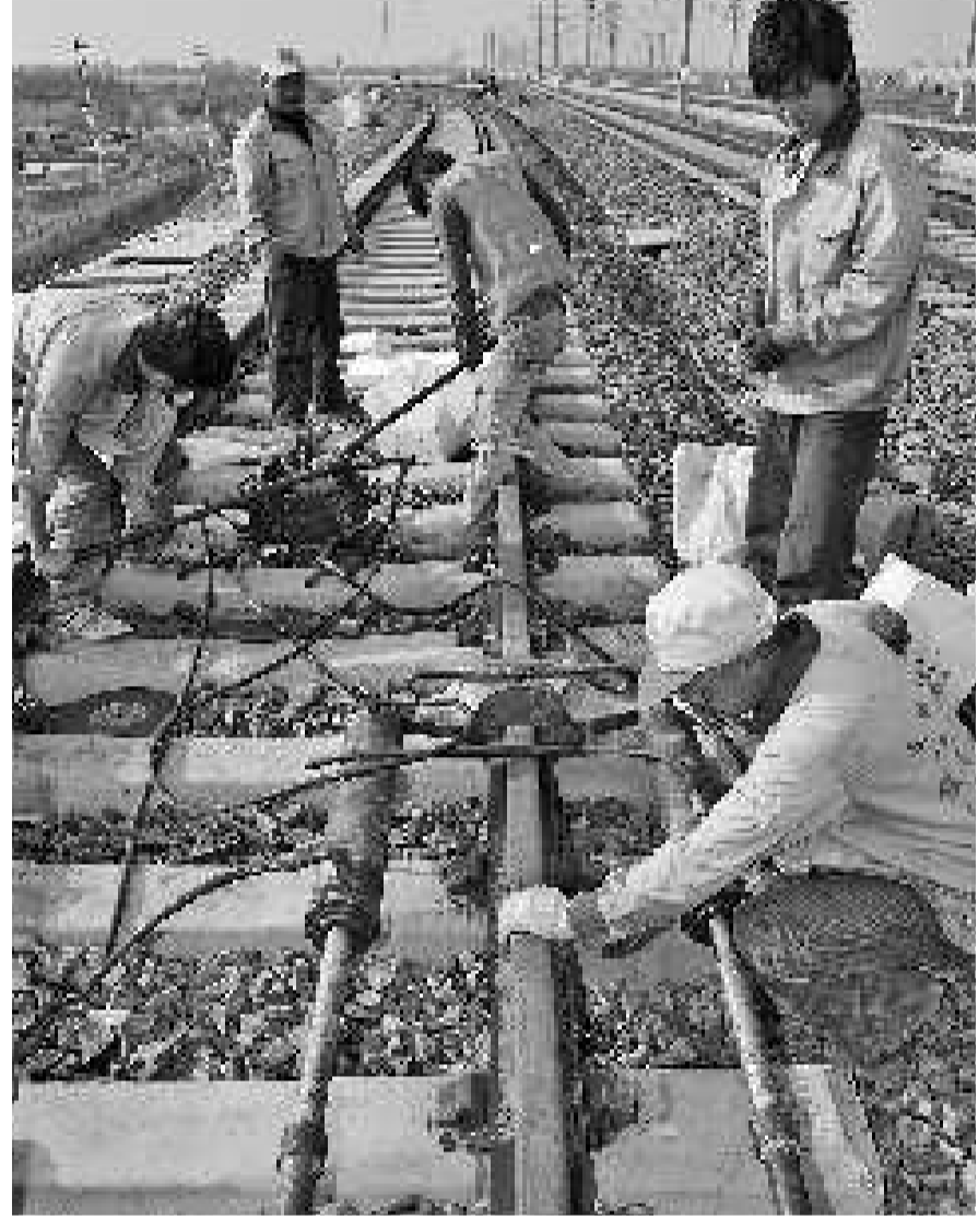
工人正在对铁轨连接处进行施工。本报记者 郭建政 摄
