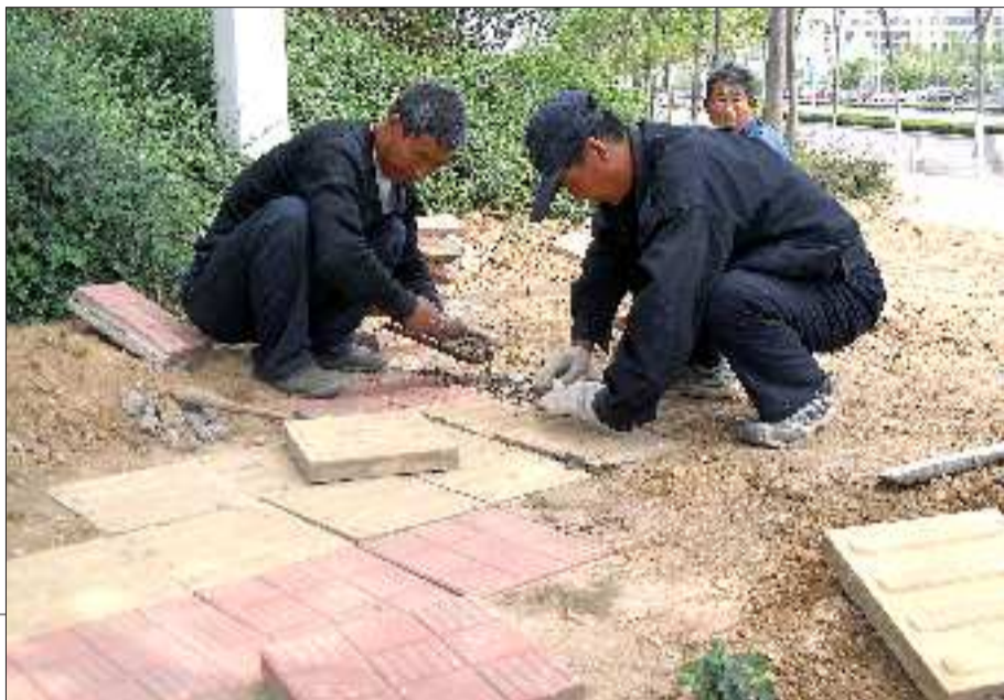
25日上午,在济南路与威海路交汇处,施工人员正在对人行道步道板进行更换。
